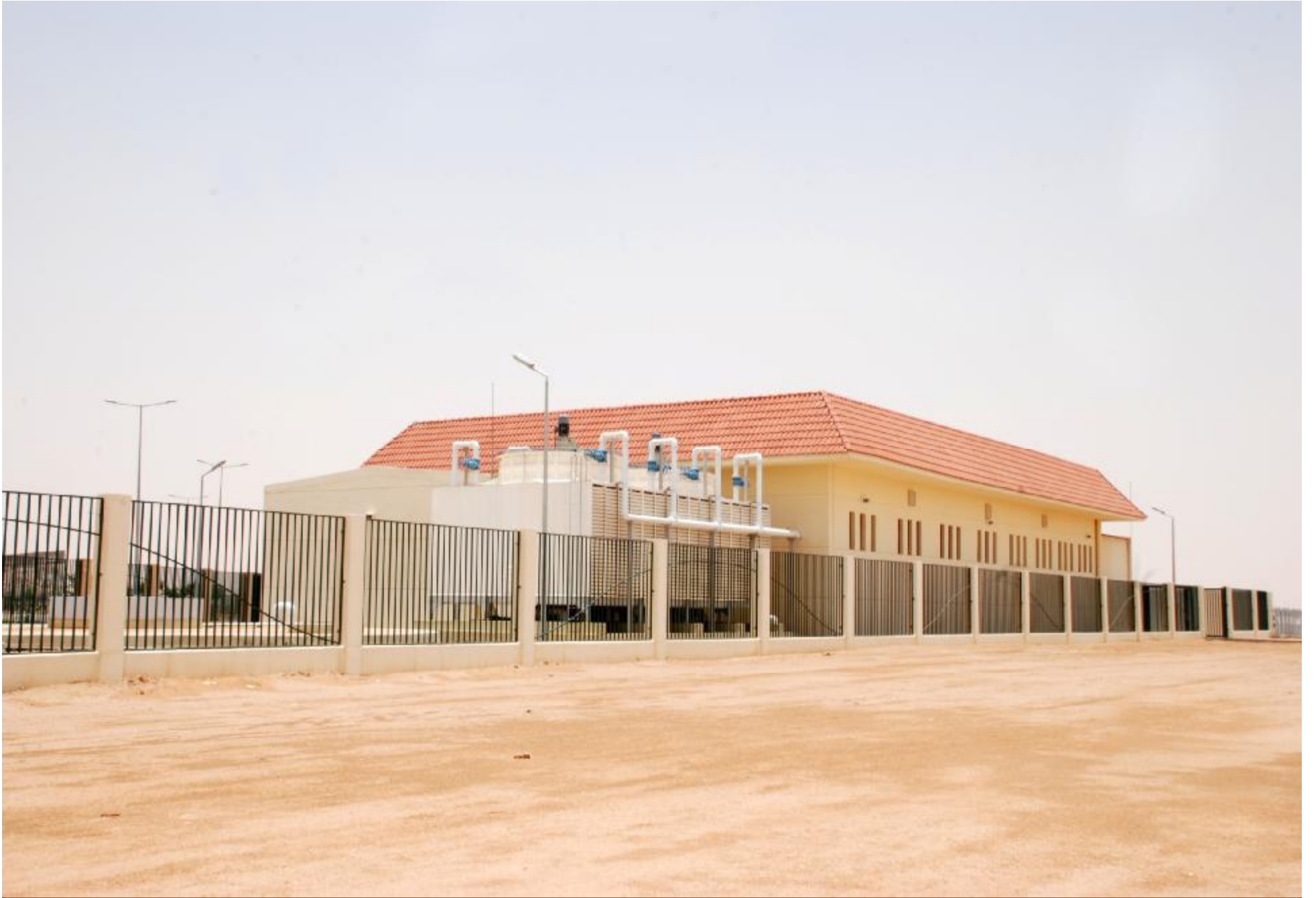
محطة تحلية المياه
