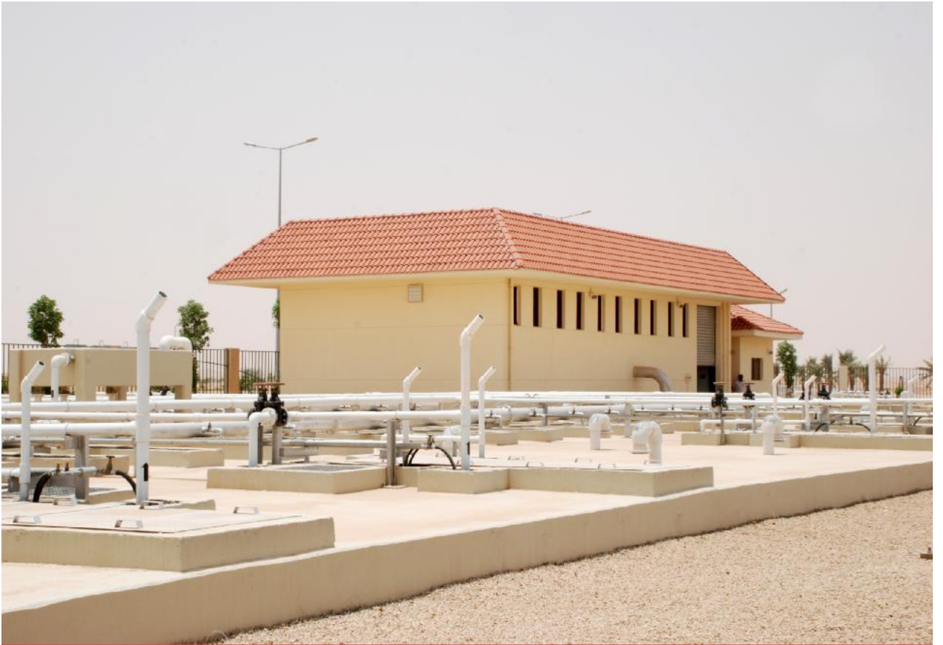
محطة تنقية مياه الصرف الصحي
